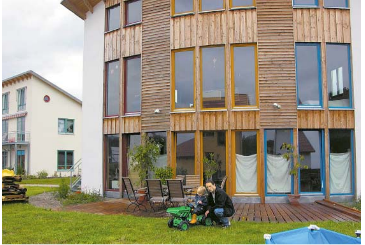
Dank guter Dämmung und der konsequenten Ausrichtung nach Süden werden die Häuser in der Ökosiedlung Neumühlen hauptsächlich von der Sonne beheizt. Reicht deren Kraft nicht aus, sorgt ein Rapsöl betriebenes Blockheizkraftwerk für Wärme. FOTO: CHRISTINA STEINACKER
